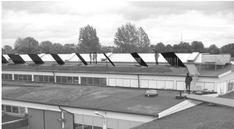
Figur 4.9 Förslag till placering av 250 \text{ m}^2 solfångare på F-byggnaden, Förrådet 6. [Fieber A. 32]
