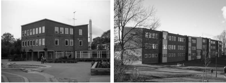
Figur 4.14 50-talsskolan i Augustenborg som är aktuell för solfångarplacering. A-byggnaden till vänster och C-byggnaden till höger. [Foto: Nilsson M.]
